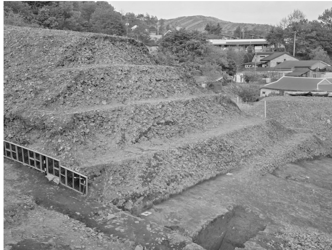
〈그림 11〉 남측 퇴적구릉 단면 절개 전경
